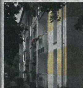
Modernisierung: An Peter- und Vormbockstraße werden 85 Wohnungen hergerichtet.
