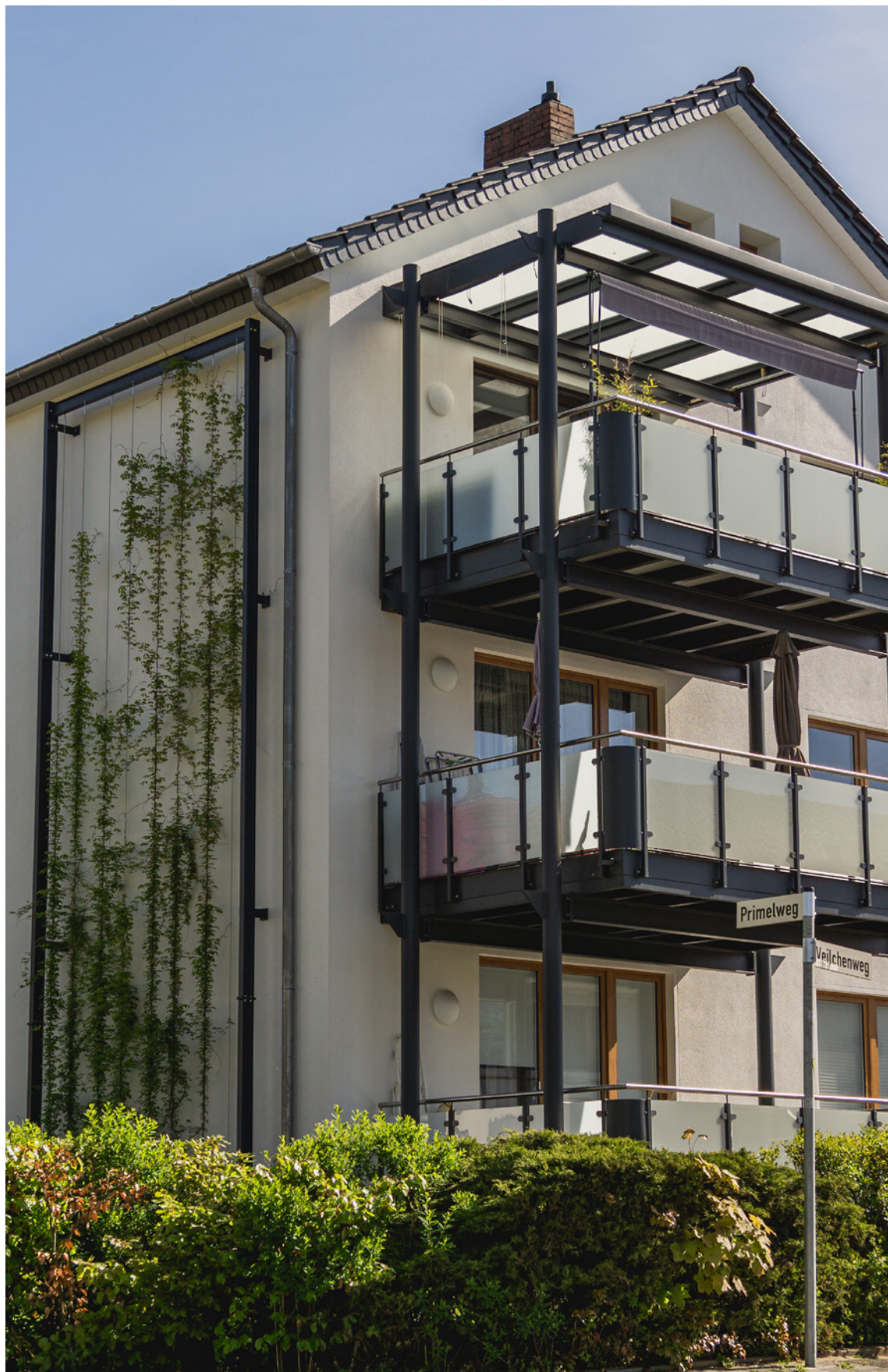
Veilchenweg/Tulpenweg nach umfassender Sanierung 2023
