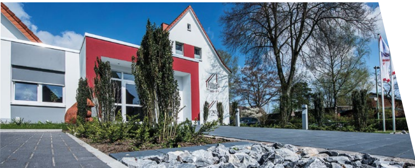
Verwaltungsgebäude GSWG Senne e.G.- Tulpenweg 5, Bielefeld
